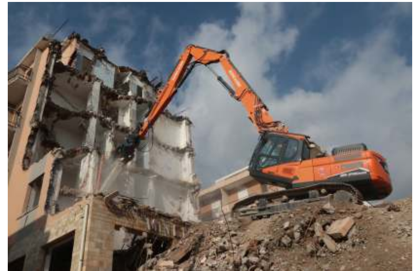
Salon Mention PDF Emanuele Zuffo, Italy, demolizione 4
